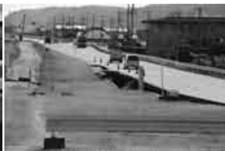
▲小見川大橋たもとでは道路が大きく損壊
