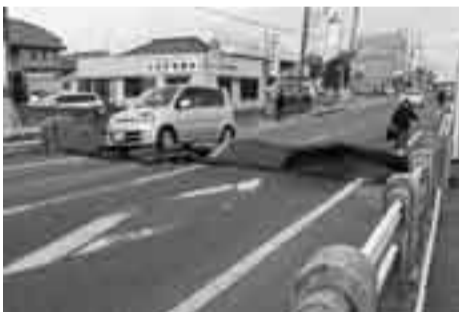
▲橋のつなぎ目付近では大規模な陥没が多発
