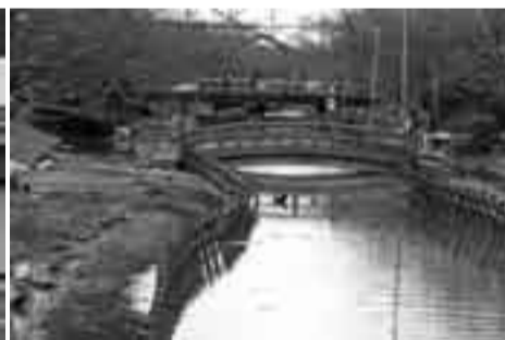
▲護岸周辺に甚大な被害を受けた十間川
