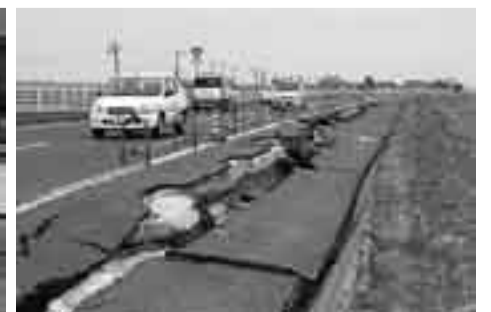
▲各地で道路が損壊（国道356号 飯島地先）
