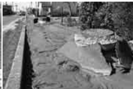
▲液状化現象によりマンホールが隆起
