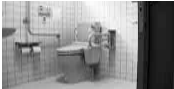
▲入り口を引き戸にし、手すりを付けたトイレ
