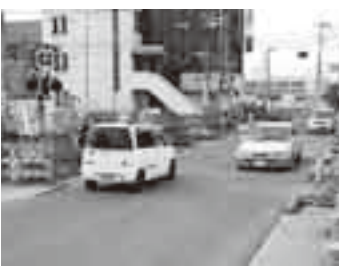
▲拡幅工事する東関戸踏切
