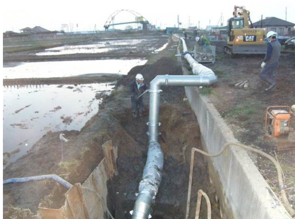
水道の応急復旧(荒川)
