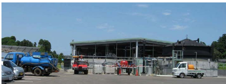
山田バイオマスプラント(新里)
