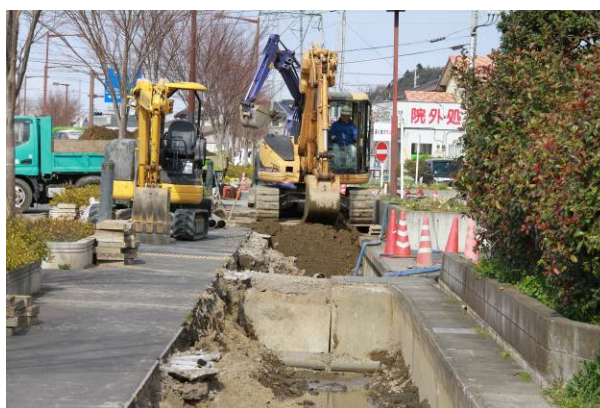
下水道の応急復旧(仁井宿)
