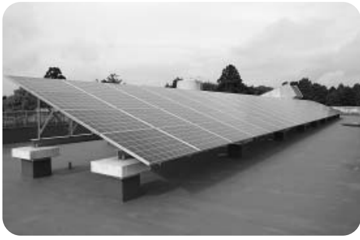
栗源中の校舎屋上に設置された太陽光パネル
