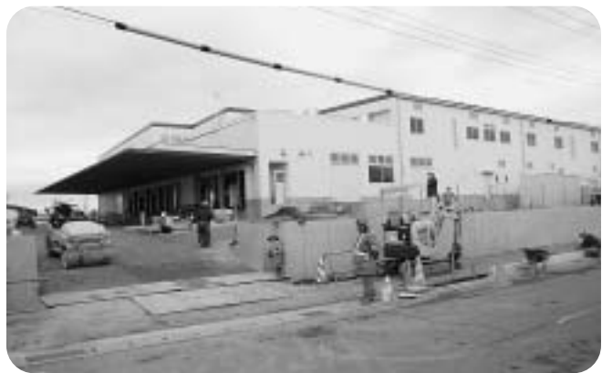
現在建設中の香取市学校給食センター
