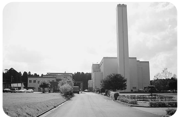
伊地山クリンセンター
