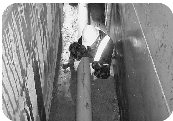
下水道管の布設工事の様子(佐原区佐原木)
