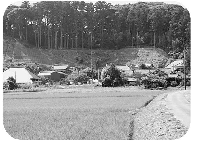
山田区田部地区玉地先の急傾斜地
