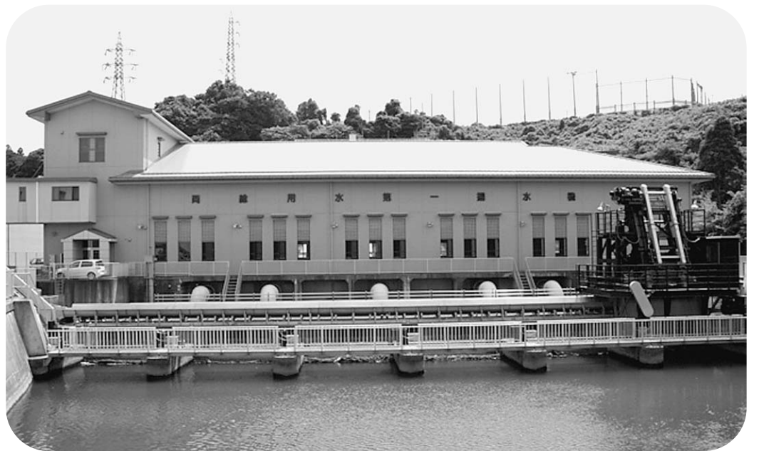
両総第一揚水機場
