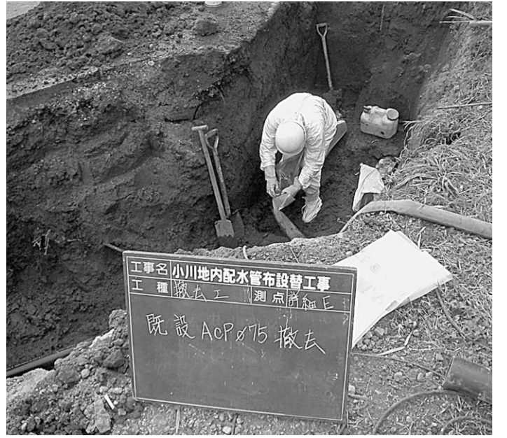
石綿セメント管の撤去作業
