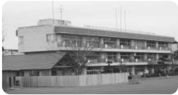
栗源小学校、増築・改修工事
