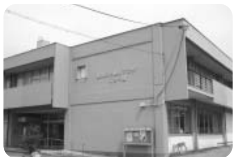
施設を廃止する小見川プラザ
