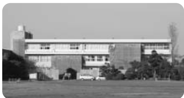
耐震補強を行っている新島中学校
