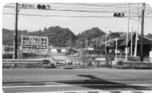
工事が進む、成田小見川鹿島港線(竜谷バイパス)
