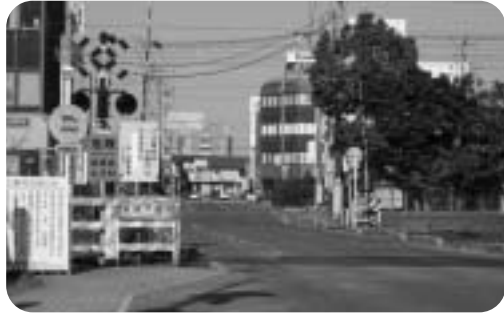
改修工事を行う東関戸踏切
