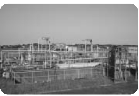
香北地区農業集落排水処理施設
