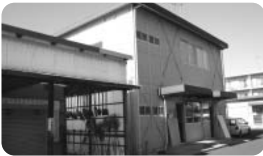
シルバー人材センター作業所
