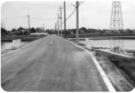
市道小見川109号線(下飯田地先)道路改良箇所
