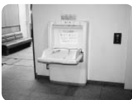
ベビーシート（本庁1階トイレ内）
