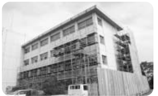
耐震補強工事を行っている小見川中学校
