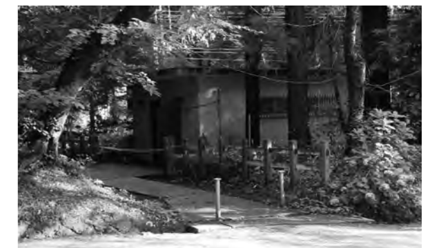
解体する香取神宮境内の公衆便所
