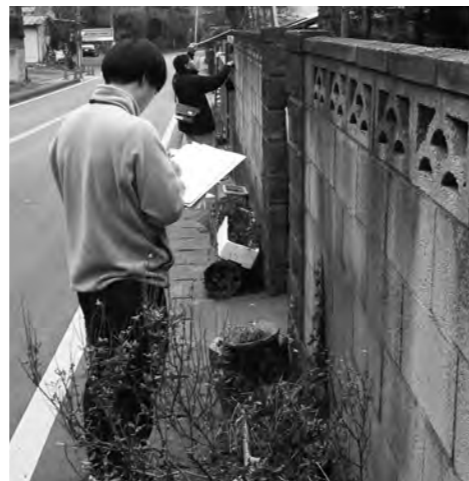
点検作業が進む通学路のブロック塀
