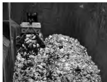
伊地山クリーンセンター焼却炉
