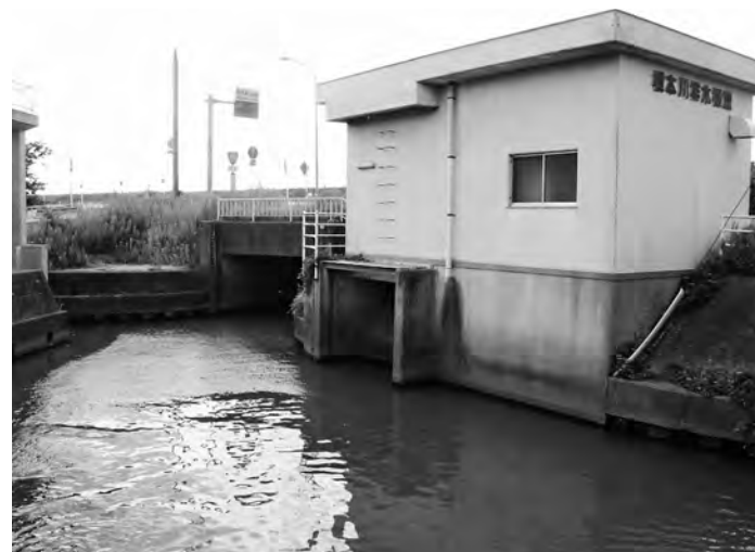
排水能力が懸念されている根本川排水機場
