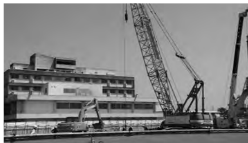
地域医療の充実を図る小見川総合病院建て替え工事
