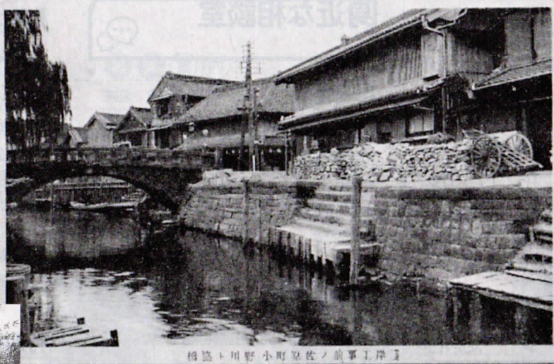
▲大正初期の「だし」(護岸工事前) 左は明治15年(1882)に架けられた石造隻眼橋の「協橋」。 その奥には木杭横矢板仕上げの護岸も見える
